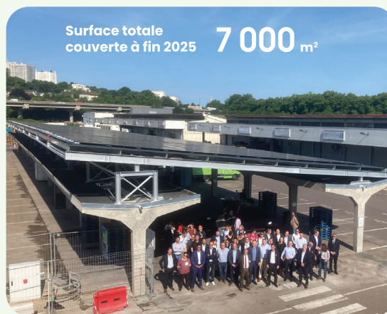
Inauguration de la centrale photovoltaïque des Hallettes, le 11 juin
